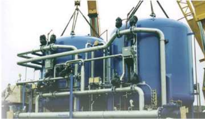
Fig. 52. Exemple de filtre sous-pression. Elimination biologique du Fe et du Mn. DEGREMONT, France.
