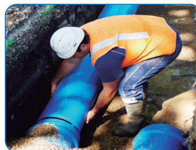
La longueur de limite d'emboîture est la distance entre l'extrémité biseautée du tuyau et la marque repère imprimée.
