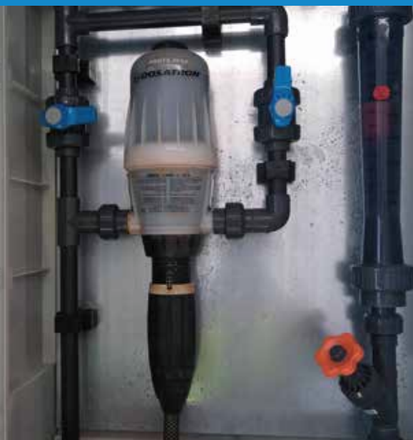
Container avec deux armoires de dosage FeCl3 et Flocculant
