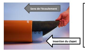
Avant le montage, desserrez complètement le mécanisme de serrage et mouiller la vanne avec de l'eau. (Éventuellement avec un peu du savon)
