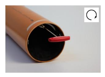
Fixez la vis dans le sens de la flèche avec l'outil d'origine. La vis doit être fixée dans la zone de la couronne du tube.
