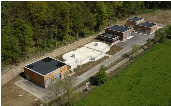
Station d'épuration de Louvain-la-Neuve : bioréacteur à membranes avec aérateurs de surface couverts
