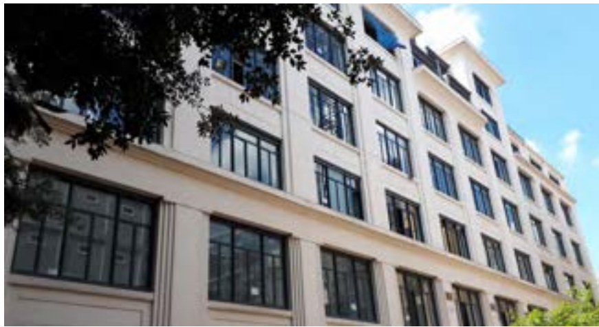
Réhabilitation et construction bâtiment Breteuil-Séguir, Paris 7ème (75)
