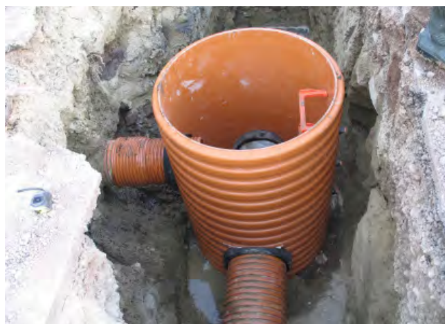
Exécutions des raccordements réalisés sur place
