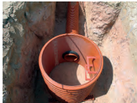
Finition du fond du regard achevé en béton (seulement recommandé sans nappe phréatique)
