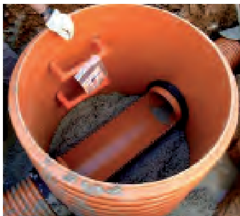
Finition intérieure d'un regard à 180°
