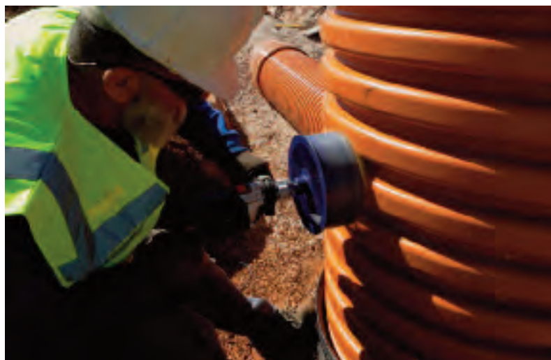
Réalisation d'un raccordement avec une couronne de coupe
