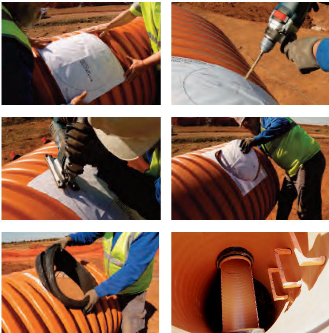
Séquence de l'installation d'un clip élastomère
