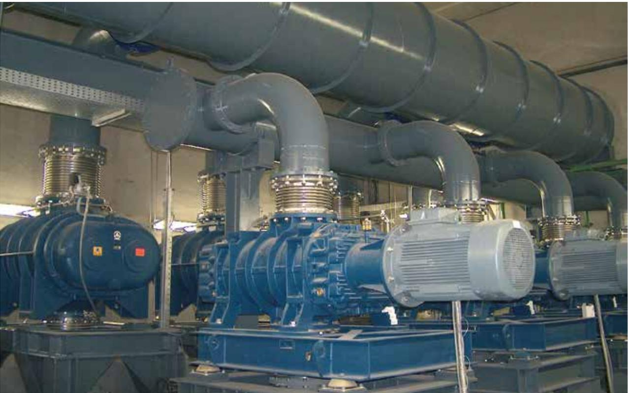
Process sous vide avec 4 étages, pour un débit volumique aspiré de  $2 \times 30\,000 \text{ m}^3/\text{h}$  pour le dégazage en aciérie
