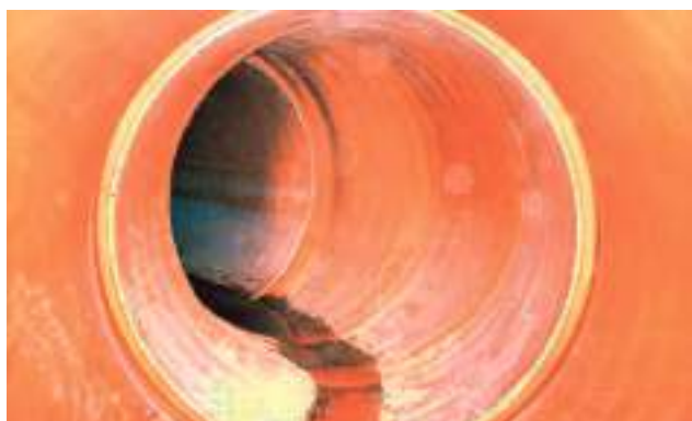
VUE INTÉRIÈRE DU COLLECTEUR SANECOR® AVEC DÉVIATION ANGULAIRE
