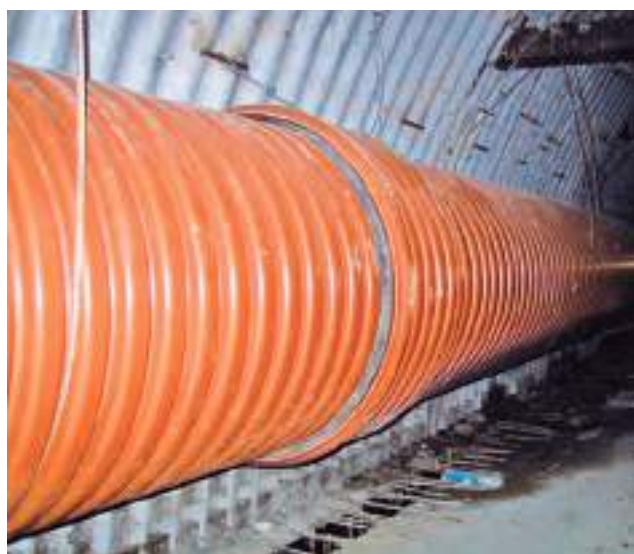
INSTALLATION DE TUBES SANECOR® EN GALERIE ET EN FOSSÉ
