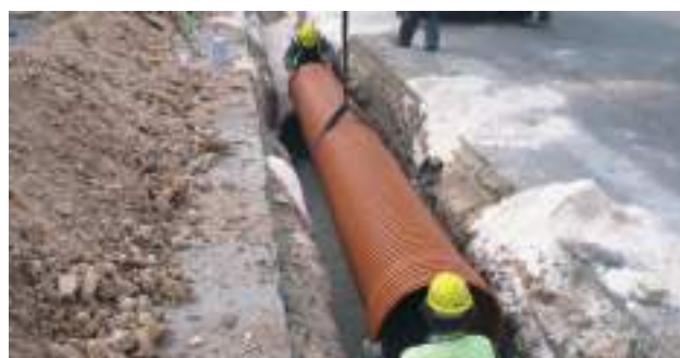
MANIPULATION SUR CHANTIER DU TUBE SANECOR®
