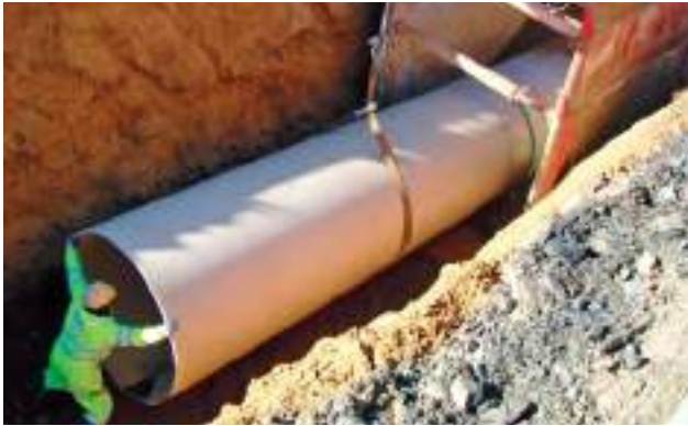
MONTAGE DE TUYAUX EN PRFV DANS UN FOSSÉ AVEC SOUTÈNEMENT
