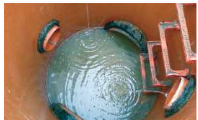
RÉALISATION DE MULTIPLES BRANCHEMENTS RÉALISÉS IN SITU
