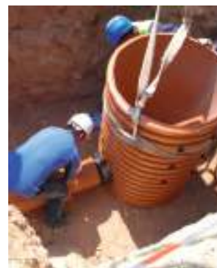
INSTALLATION DE TUBES AU CORPS DU REGARD
