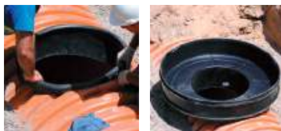
INSTALLATION DU CORPS AVEC BASE DE REGARD
