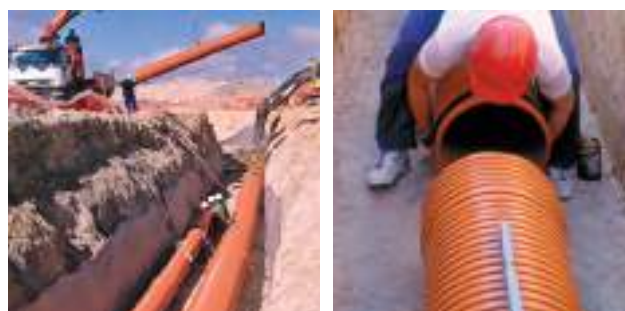
SUR LA GAUCHE, MONTAGE DE TUYAUTERIES SANECOR® AVEC MOYENS MÉCANIQUES DISCRETS (DIAMÈTRES MOYENS ET GRANDS). SUR LA DROITE, UNION MANUELLE (DIAMÈTRES PETITS)
