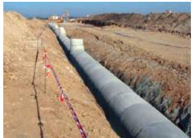
COLLECTEUR EN BÉTON ARMÉ
