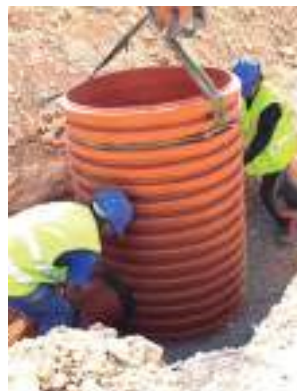
INSTALLATION DE TUBES AU CORPS DU REGARD
