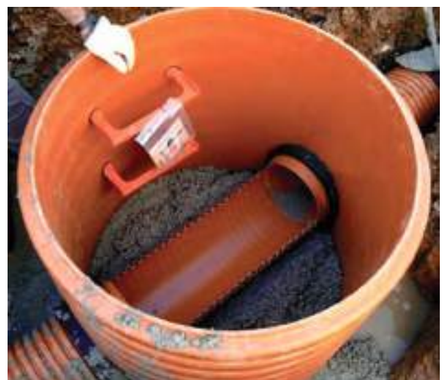
BÉTONNAGE DU FOND DU REGARD - 2ÈME PHASE
