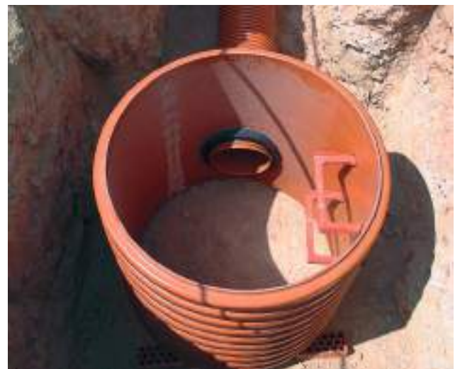
BÉTONNAGE DU FOND DU REGARD - 1ÈRE PHASE
