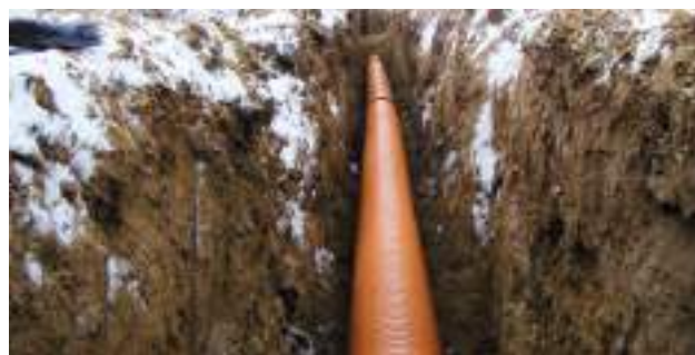
VUE DE TUBE SANECOR® INSTALLÉE DANS LE FOSSÉ
