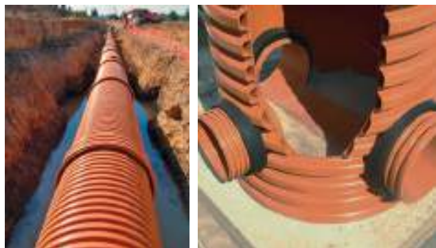
LE CORPS DU REGARD SANECOR® EST FABRIQUÉ AVEC UN TUBE SANECOR® SN8
