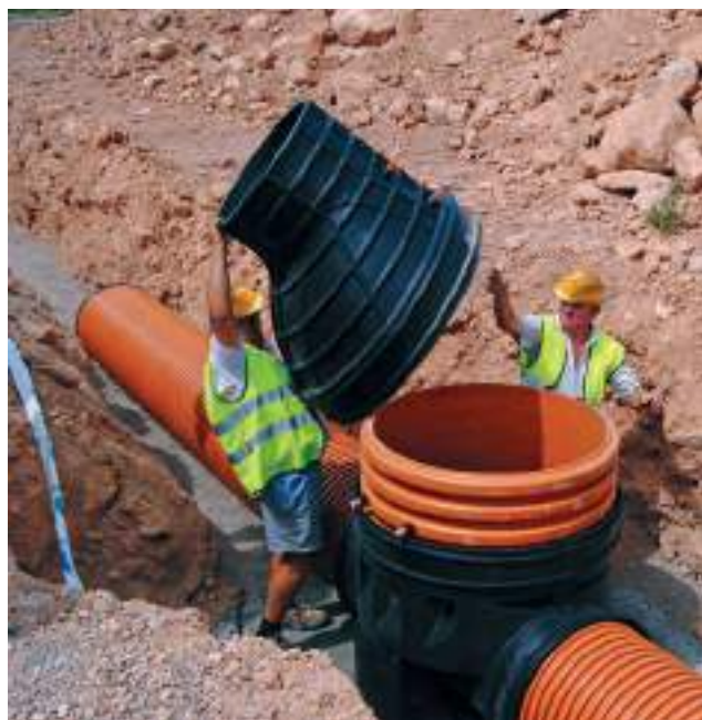
INSTALLATION DE PIÈCE EMBRANCHEMENT DE PASSAGE TOTAL
