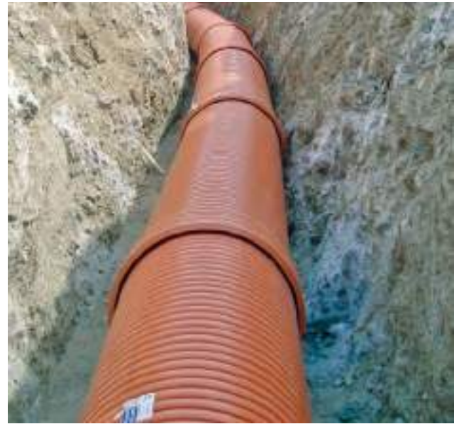
TUYAUTERIE SANECOR® DE 1200 MM AVEC DÉVIATION ANGULAIRE
