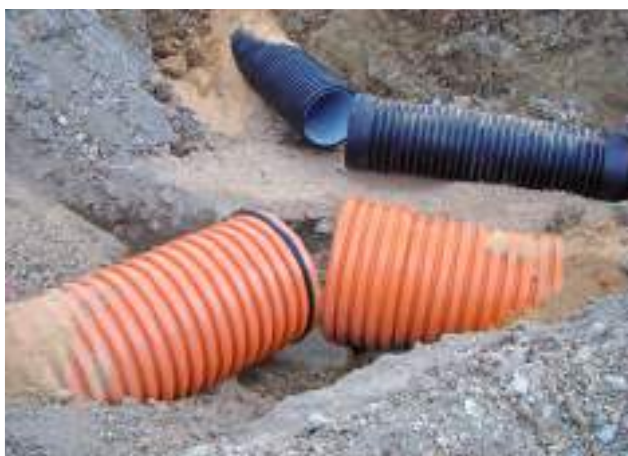
TUBES EN PVC ANNELÉ (COULEUR TUILE) ET EN PE ANNELÉ (COULEUR NOIRE)
