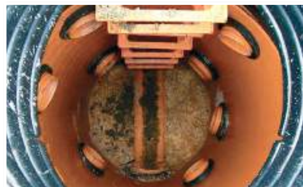
RÉALISATION DE MULTIPLES BRANCHEMENTS RÉALISÉS IN SITU
