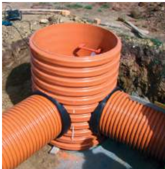
INSTALLATION DE REGARDS SUR COLLECTEURS AVEC CHANGEMENT DE DIRECTION
