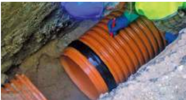
CONNEXION MANUELLE DE TUBES ANNELÉS
