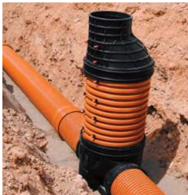
INSTALLATION DE PIÈCE EMBRANCHEMENT DE PASSAGE TOTAL
