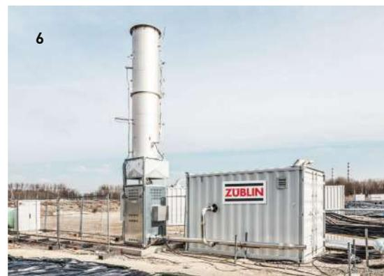
1 Filtres charbon actif air, régénérables par vapeur, Berlin / 2 Filtres charbon actif air, Suisse / 3 CATOX, Allemagne de l'Est / 4 Mesure d'air GC, Suisse / 5 RTO, Allemagne de Sud / 6 TO torçhère haute température, Allemagne de Sud /
